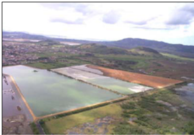
Figura1. Bacia de sedimentação para descarte de resíduos
